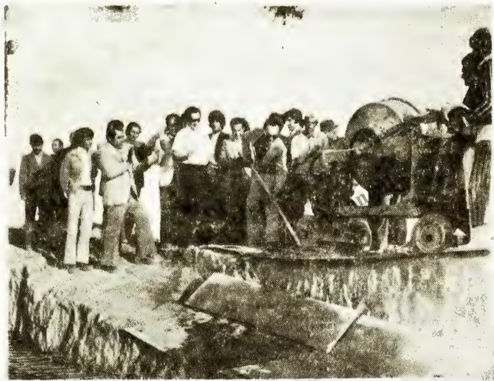
آقای جابری انصاری وزیر مسکن و شهر سازی در شهر کرد و گزارش مدیر کل مسکن و شهر سازی چهارم حال در باره بتن ریزی ۸۸ دستگاه آبار تمان ۲ اطاقه ۳ اطاقه و ۴ اطاقه در دست ساختمان
