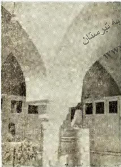
وضع ساختمان داخلی رخت کن و سقف گرمابه اتابکان
